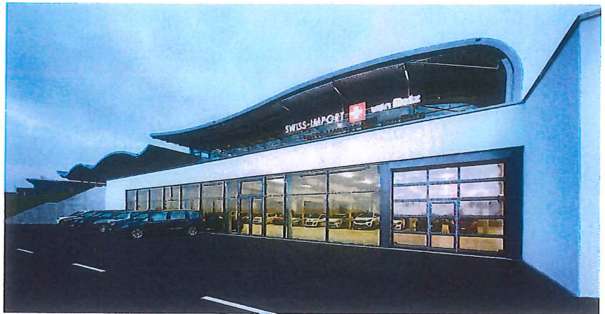
Das verglaste Untergeschoss des Neubaus bietet Reserveflächen und Zukunftsoptionen.
